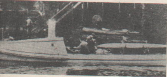
Prototyp kutra torpedowego Dragonfly z torpedą zrzucałą na burtę (1905 r.)
